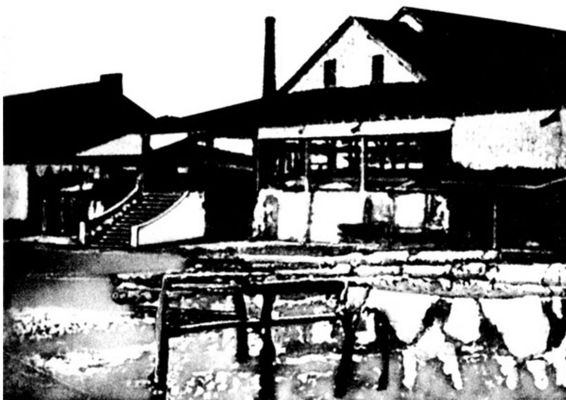
FIG. 12. Saladero moderno con su anexo de grasería. Aunque basado siempre en un sistema que desperdiciaba la mayor parte del animal, se observan grandes progresos respecto al establecimiento de la fig. 6. Tomado de DAIREAUX, La estancia argentina.
